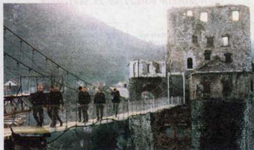
Bilder wie dieses von der berühmten im Jugoslawienkrieg zerstörten Brücke von Mostar prägen unsere Vorstellung vom Balkan. FOTO: DPA
